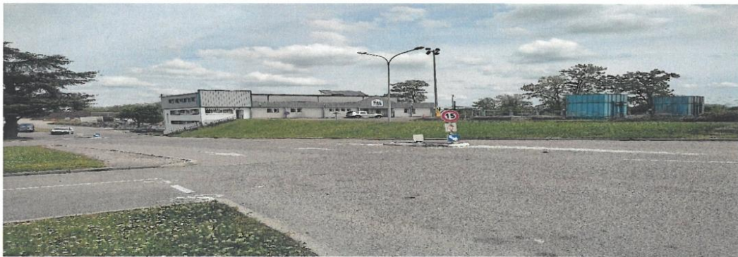
Quai de Transfert – Vestiaires
