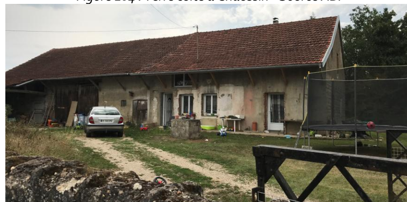
Figure 165 : Débord de toit à Petit-Noir
