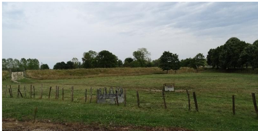
Figure 95 : Digue de Longwy-sur-le-Doubs
