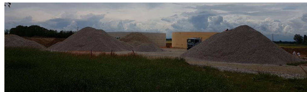
Figure 92 : chantier de l'unité de méthanisation
