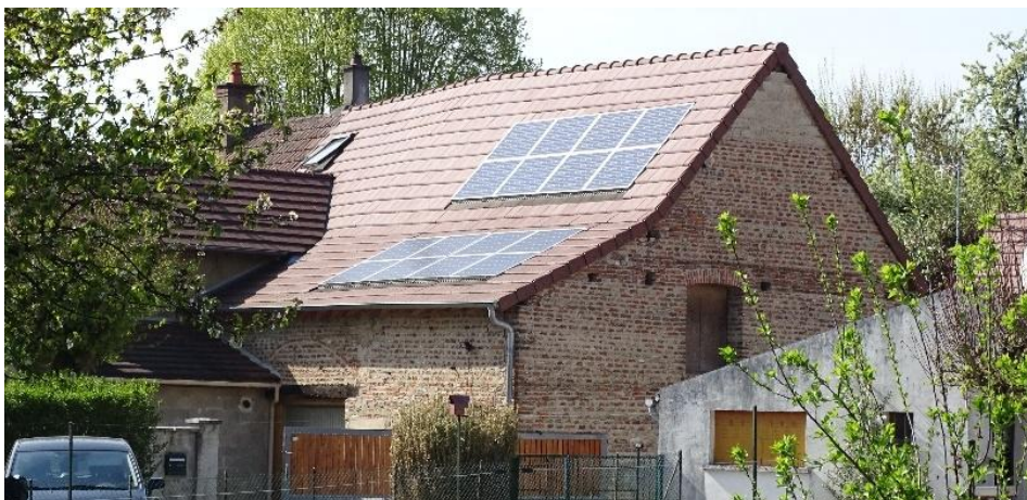
Figure 90 : Production photovoltaïque individuelle à Chaussin
