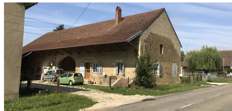
Figure 158 : Toiture long-pan à Pleure
