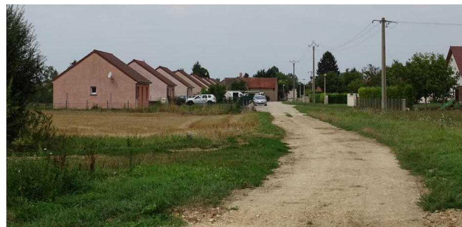
Figure 231 : La production de logement sous forme pavillonnaire en extension urbaine à Petit-Noir
