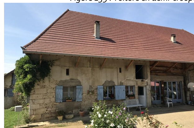
Figure 160 : Toiture en croupe – Rahon
