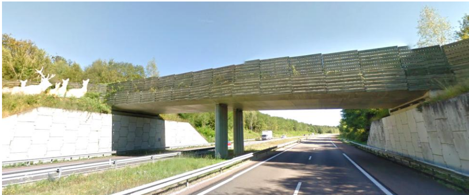
Figure 68 : Passage à faune sauvage sur l'A39 à Rahon
