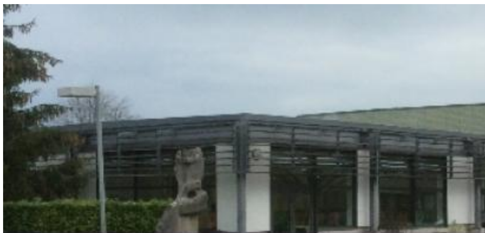
Figure 176: Le collège Marcel Aymé - Source collège Marcel Aymé
