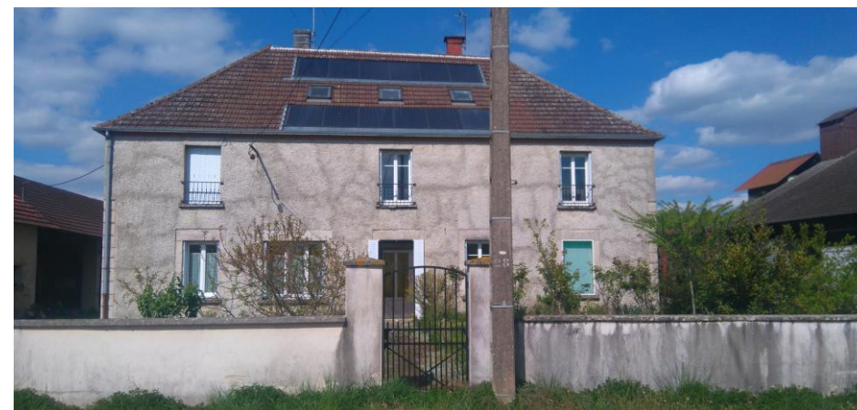
Figure 91 : Installation de panneaux solaires à Saint-Loup
