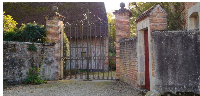
Figure 150 : Mur et Portail en brique à Chaussin - Source UDAP
