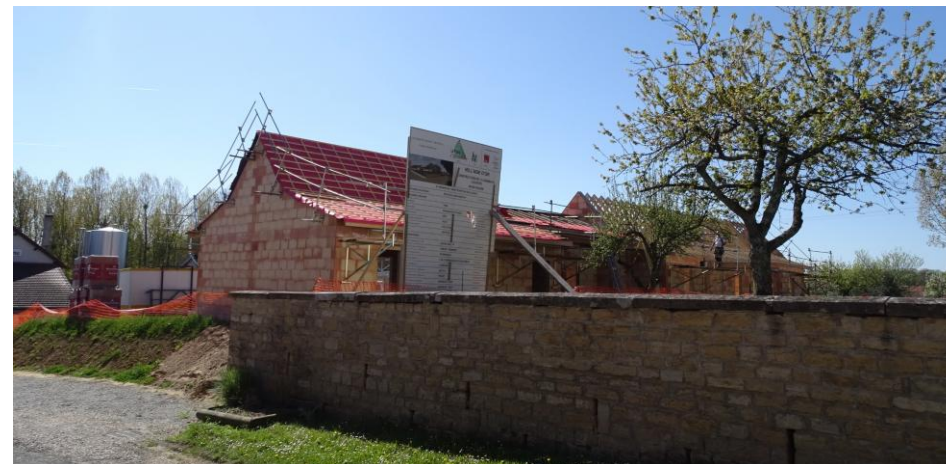
Figure 196: Construction de logement locatif à Pleure
