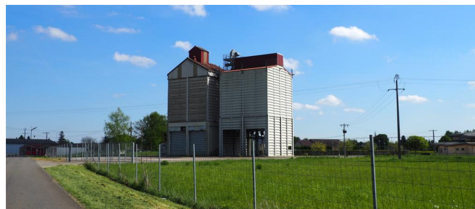
Figure 122 : Hangars agricoles à Beauchemin (Chemin) et silo à Petit-Noir
