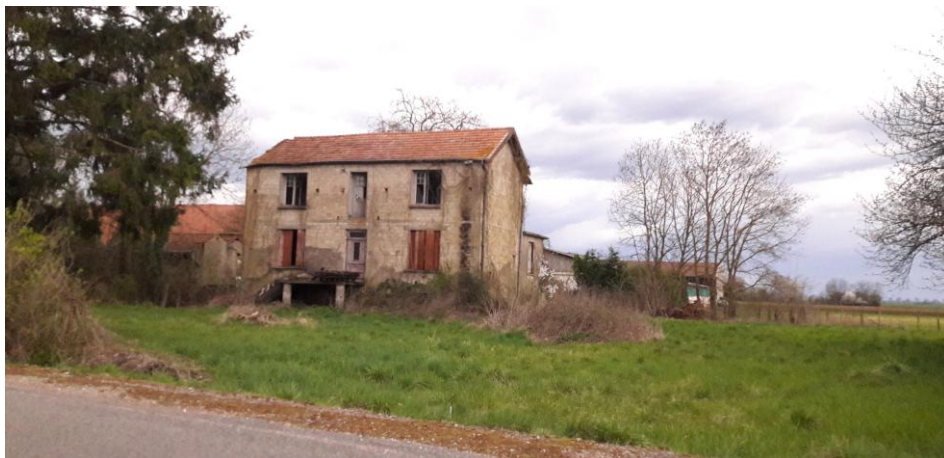
Figure 193 : Une maison vacante à Longwy-sur-le-Doubs
