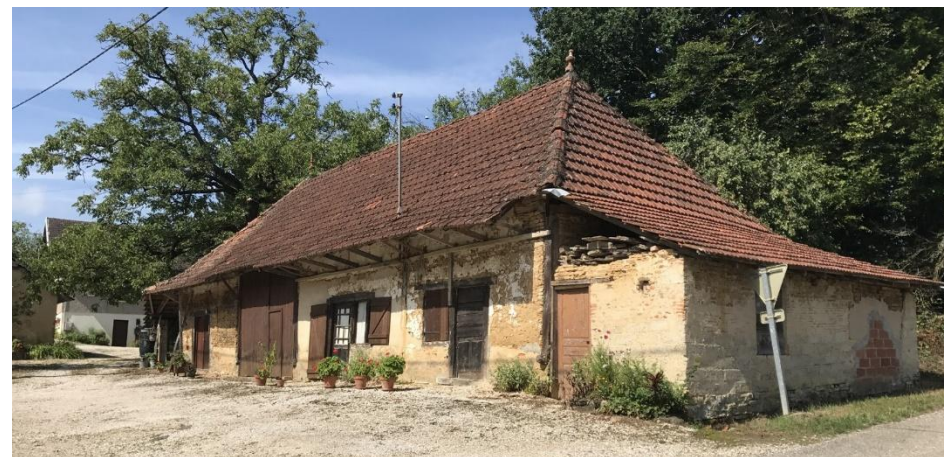
Figure 143 : Détail d'une ferme bressane – Pleure
