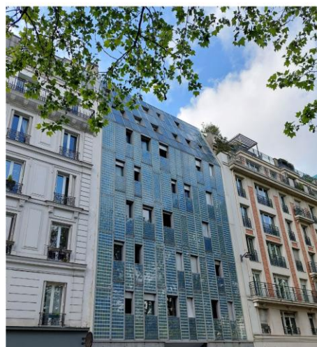
Façade photovoltaïque, Paris - F. Saadi, architecte, © Roland Pelletan
