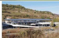
Couverture de parking, Crêt de la Neige (12). © Olivier Leroy-Mé
