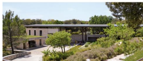
Panneaux photovoltaïques sur la maison d'accueil du Grand Site de France, Aves d'Origny, ©Françoise Proffhormer
