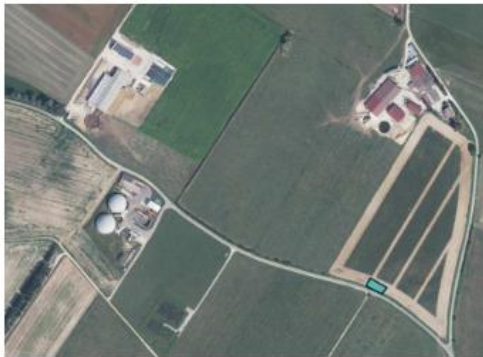
Localisation de la zone de croisement par rapport à l'accès (rectangle vert)
