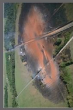
Conséquences d'une fuite sur une canalisation de transport, Appomattox (USA), 14 septembre 2008 (source : brunet.org ).
