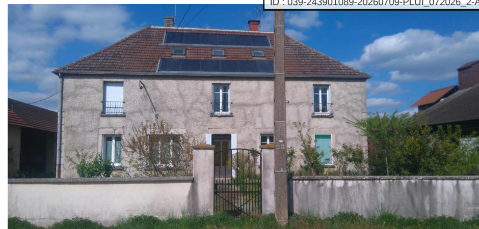
Figure 91 : Installation de panneaux solaires à Saint-Loup
