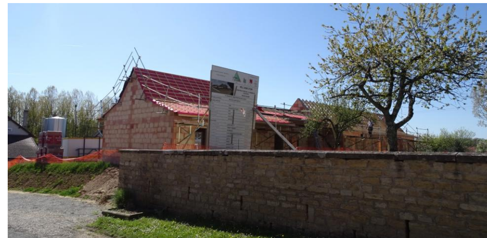
Figure 196: Construction de logement locatif à Pleure
