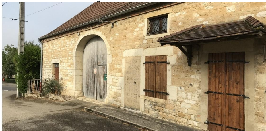
Figure 167 : Porte de grange à Asnans-Beauvoisin
