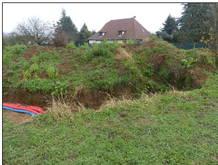
Figure 46. Vue du secteur n°5
