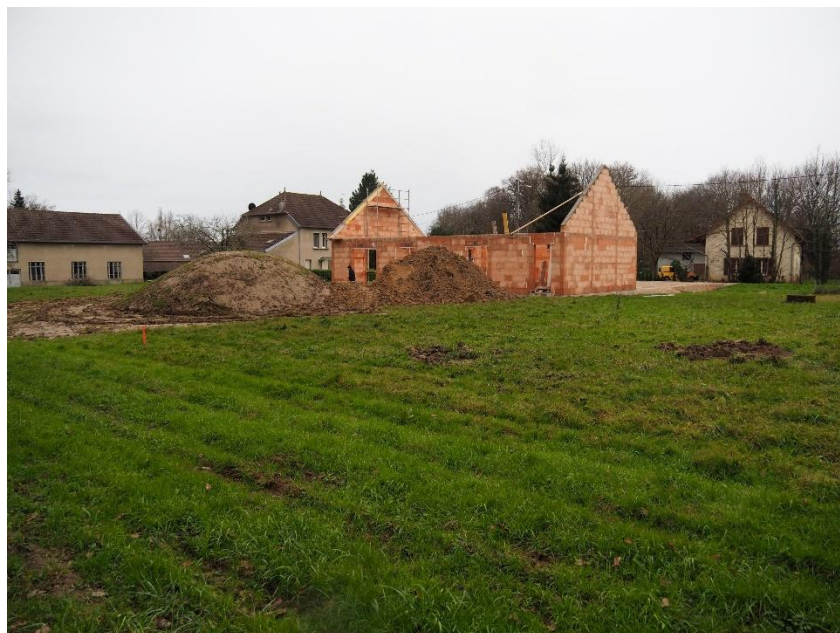
Figure 260. Vue du secteur n°51
