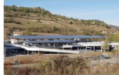
Oratoire de parking, Orsières (12). © Pierre Levrault
